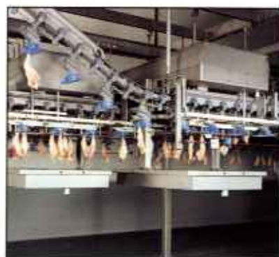
Reenganchador selectivo a línea ACM-MX independiente.
